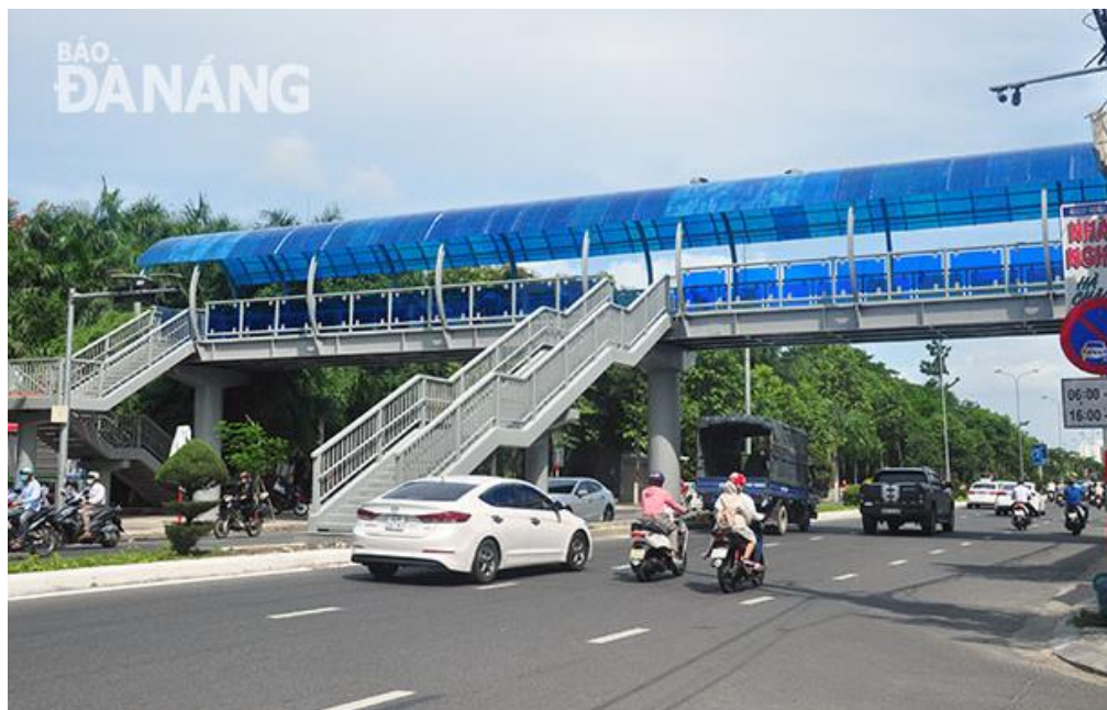
Cầu đi bộ vượt đường Nguyễn Tri Phương, Đà Nẵng
