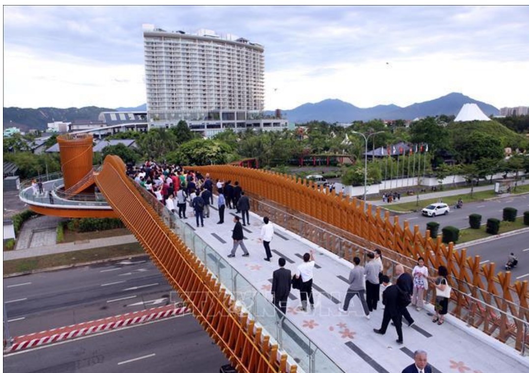
Cầu đi bộ vượt đường Nguyễn Tất Thành, Đà Nẵng
