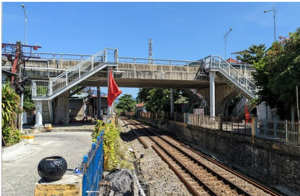
Cầu vượt Ngô Sĩ Liên, ĐN cho người đi bộ tại khu vực giao nhau với đường sắt
